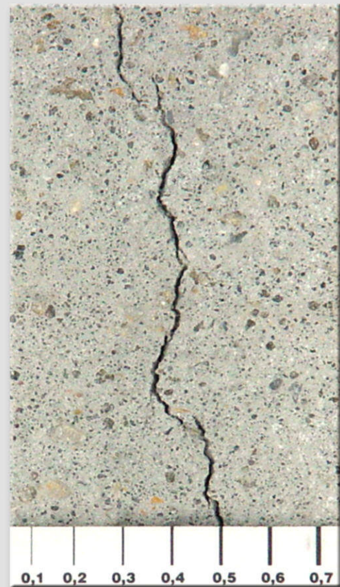
Vergrößerung eines Risses im Bereich des Füllbetons
