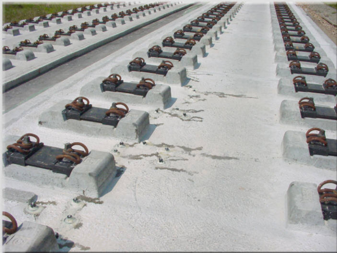
Vergrößerung eines Risses im Bereich des Füllbetons
